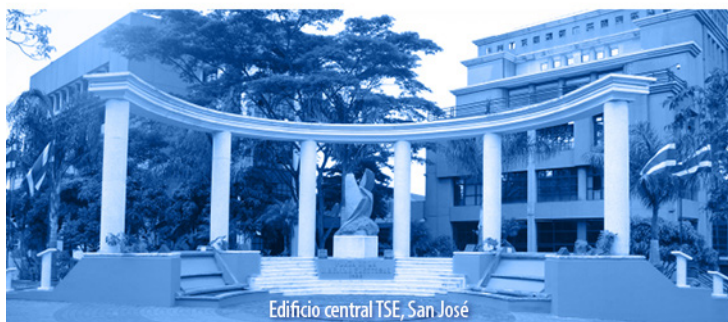
Edificio central TSE, San José
